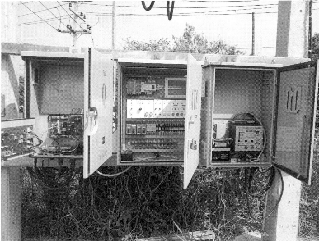
รูปที่ 4.4 การติดตั้งทดสอบเครื่องควบคุมแบบตรรกะที่โปรแกรมได้
