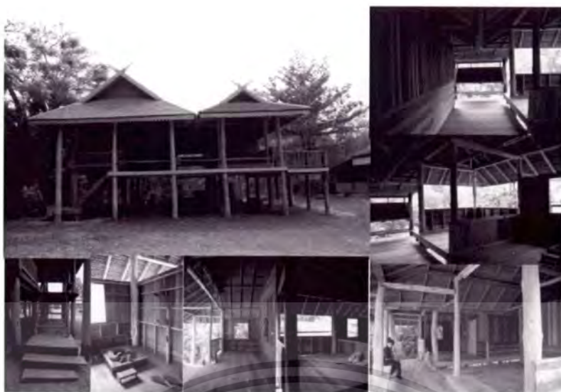
ภาพที่ 2.8 แสดงลักษณะทางสถาปัตยกรรมพื้นถิ่น ไม้ลื้อ เรือนอนุรักษ์ บ.ได้รัมย์โพธิ์ทอง ต.งอบ อ.ทุ่งช้าง จ.น่าน อยู่ในระหว่างดำเนินการก่อสร้าง
