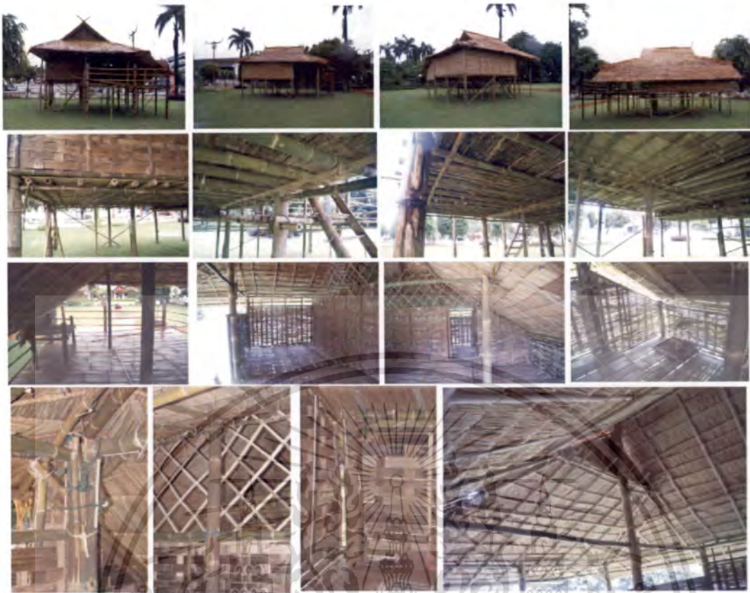
ภาพที่ 3.38 แสดงภาพถ่ายส่วน รูปด้าน,โครงสร้าง,สภาพแวดล้อมภายใน,และรายละเอียดทาง โครงสร้าง ของ อนุรักษ์ไทลื้อ ศูนย์บริการนักท่องเที่ยว อ.เมือง จ.น่าน
