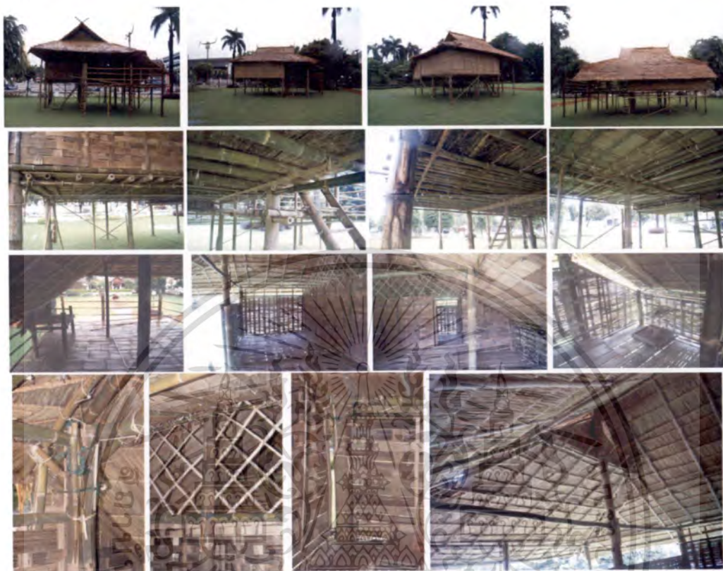
ภาพที่ 5.28 แสดงลักษณะทางเทคโนโลยีสถาปัตยกรรมพื้นถิ่นเรือนเครื่องผูก ชาวไทลื้อ จ.น่าน จากเรือนสาธิต จัดแสดงชั่วคราว เมื่อปี พ.ศ. 2553 ที่ลานศูนย์บริการนักท่องเที่ยว จ.น่าน
