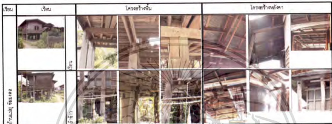
ตารางที่ 4.26 แสดงระบบโครงสร้างเรือนพักอาศัย เรือนพักอาศัย แม่สุ ชุมชนไทลื้อ บ้านร่องแง ต.วรนคร อ.บัว อายุเรือน 35 ปี
