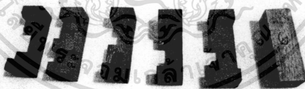
ภาพที่ 2.1.11 แสดงลักษณะของการบากเดือยของไม้แต่ละชั้นของ เถรอดเพลแบบที่ 2
