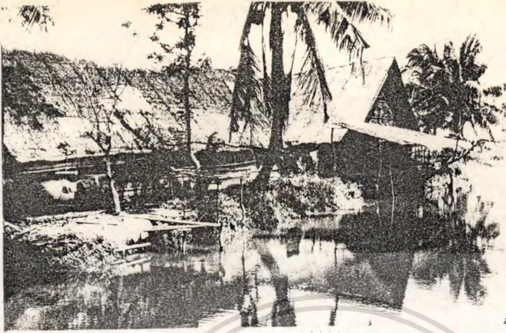
มองจากทางเข้า ถิ่นหลัง
