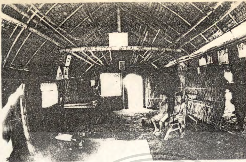
ห้องโถงภายในโรงนา ส่วนนั่งเล่น และพักผ่อน กรณีนี้แสงสว่างภายใน ใช้แสงจากช่องประตู และหน้าต่าง
