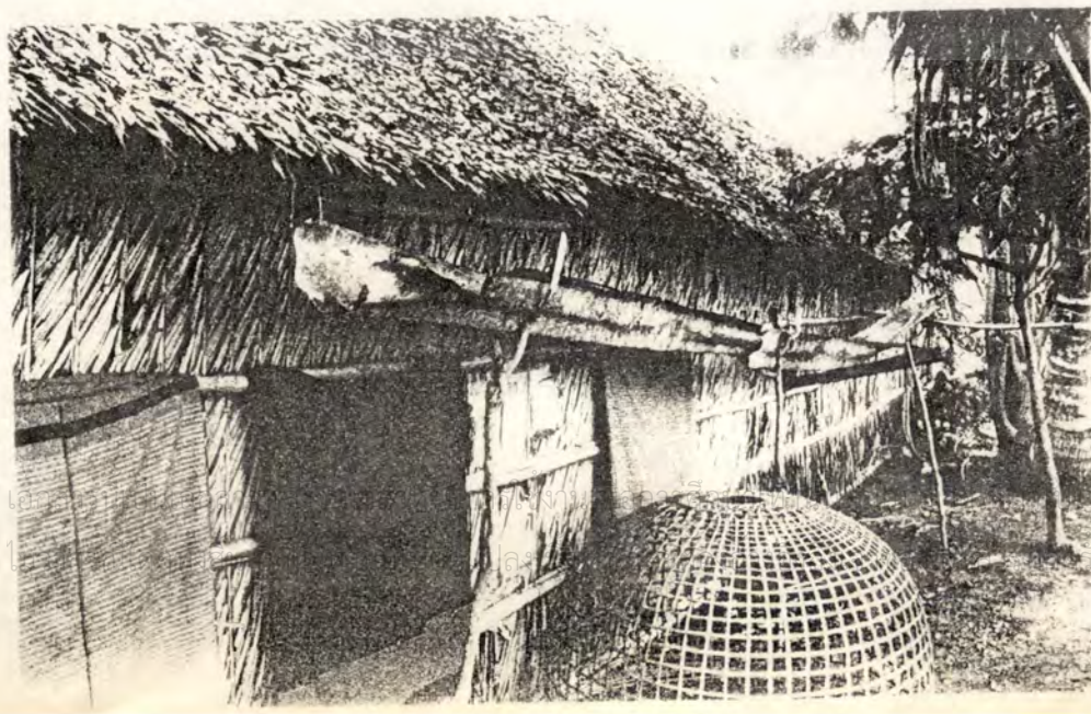
ลักษณะ ฟางข้าวขณะ และ รางน้ำ ระบายน้ำ
