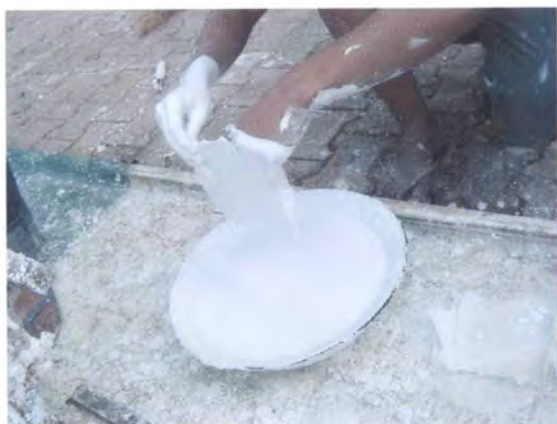
ภาพที่ 7 ผสมปูนพอเหลว ใช้ผ้ากระสอบหรือใยแก้วจุ่มปูนแล้วจึงนำไปวางบนผิวปูนชั้นแรกที่สลับไว้จนทั่ว โดยวางให้เหลื่อมกันเล็กน้อย
