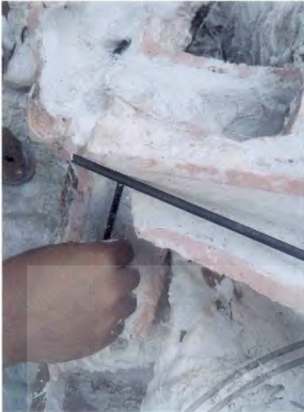
ภาพที่ 13 ในตำแหน่งที่สำคัญโดยเฉพาะข้อพับหรือบริเวณที่รับน้ำหนักสามารถเลือกใช้เหล็กที่มีขนาดใหญ่เพื่อเพิ่มความแข็งแรงได้
