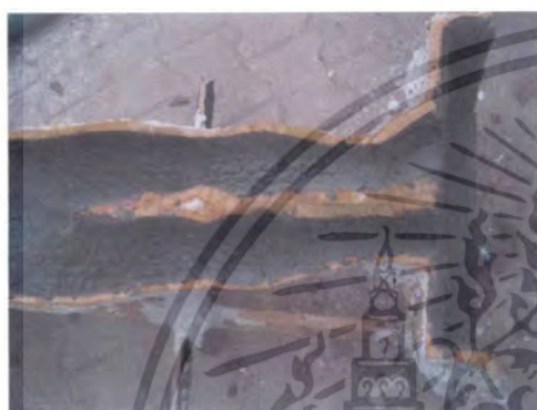
ภาพที่ 8 จากนั้นรอจนกว่าปูนเปลี่ยนสีเป็นสีเข้มจึงใช้เครื่องมือขีดพื้นผิวเป็นเส้นหยาบๆ
