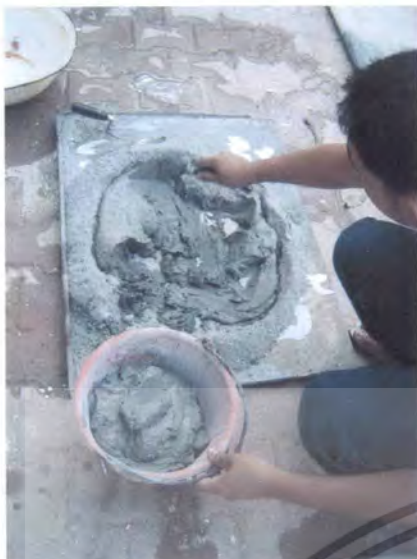
ภาพที่ 4 ผสมปูนในสัดส่วนปูนซีเมนต์ 4 ส่วน กับทรายละเอียด 1 ส่วน และเทน้ำ ลงบนปูนที่ละเอียดค่อยๆคนผสมกัน โดยให้ปูนมีความเหนียวพอสมควร
