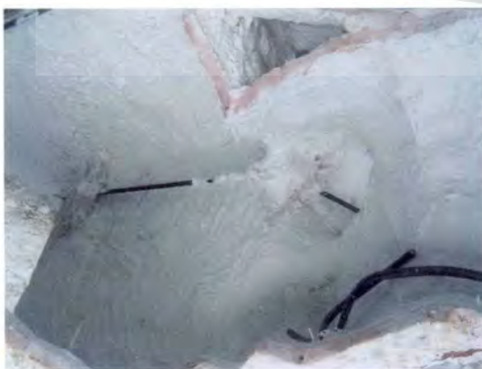
ภาพที่ 15 การตามโครงเหล็กให้ติดกับปูนชั้นที่สองเน้นการตามตามโครงสร้าง โดยเฉพาะข้อต่อหรือข้อพับ โดยเริ่มจากจุดที่สำคัญๆ ก่อนเพื่อให้โครงเหล็กติดกับปูนผิวแรกอย่างแข็งแรง
