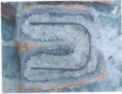
ภาพที่ 13 ตัดเหล็ก 2-3 หุนให้เข้ารูปตามโครงสร้างภายใน โดยให้ความสำคัญตามลักษณะสัดส่วนของพิมพ์
