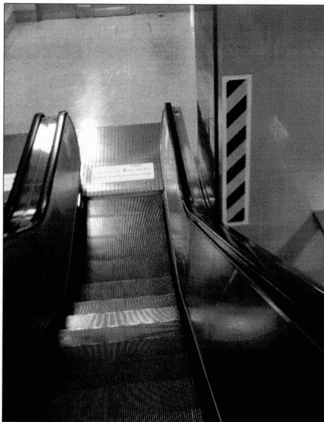
รูปภาพ 5.5 เสาข้างบันไดเลื่อนทำแถบสีตัดกันคาดไว้เพื่อป้องกันคนชะโงกชนเสา
