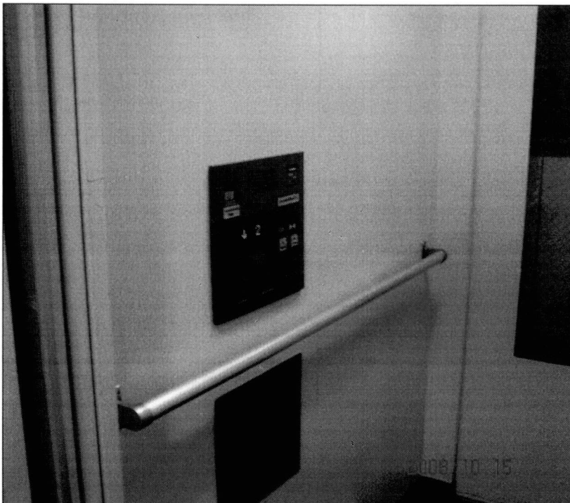
รูปภาพ 5.6 แผงปุ่มกดลิฟต์ที่มีเสียงสัญญาณ อักษรเบรลล์และราวพุงตัวในลิฟต์
