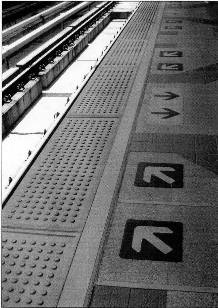
รูปภาพ 5.3 ตัวอย่างแผ่นปูพื้นขอบทางรถไฟฟ้า BTS
