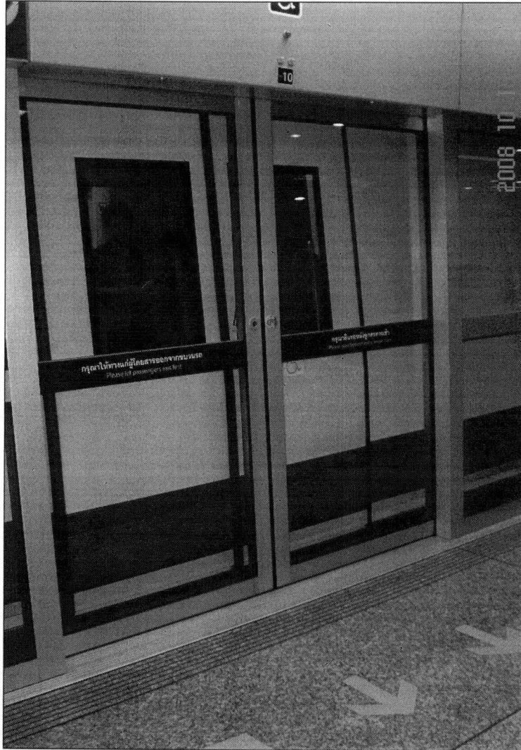
รูปภาพ 5.4 ชานชาลารถไฟฟ้าใต้ดินใช้การเซาะร่องแผ่นแกรนิตปูพื้นที่ขอบชานชาลาเพื่อเตือนอันตรายและมีประตูปิดซึ่งมีความปลอดภัย
