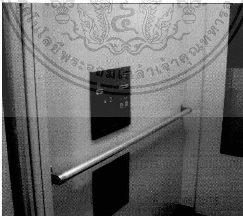
รูปภาพ 5.6 แผงปุ่มกดลิฟต์ที่มีเสียงสัญญาณ อักษรเบรลล์และราวพยุงตัวในลิฟต์
