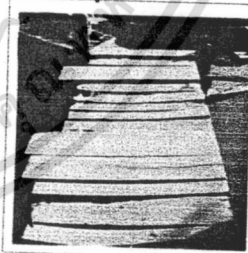
๖ รายละเอียดส่วนพื้นทางเดิน เป็นไม้แผ่นเรียงยาวเป็นแนวทางเดินภายในอาคาร
