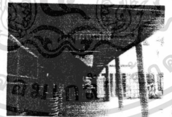
๕ รายละเอียดส่วนเสาโครงสร้างเป็นแบบเสาที่อนเดียวเส้นผ่าศูนย์กลางประมาณ 10-15 เซนติเมตร
