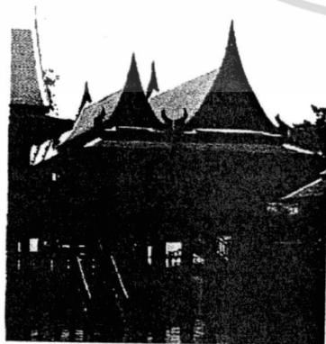
รูปที่ 2.16 ลักษณะการสร้างพื้นที่ระเบียงแบบเรือนแฝดชนิดใช้ซื่อคัดแทนเสา
