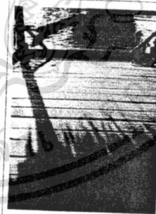
๔ รายละเอียดส่วนวัสดุปูพื้นในอาคาร พื้นเรือนไทยนิยมไม้พื้นกว้าง ปูบนคางหรือบนรอด เพื่อเป็นที่พักผ่อนอยู่อาศัย ระหว่างแผ่นต่อแผ่นของพื้นมีเคือไม้แสมคอกยึดพื้น
