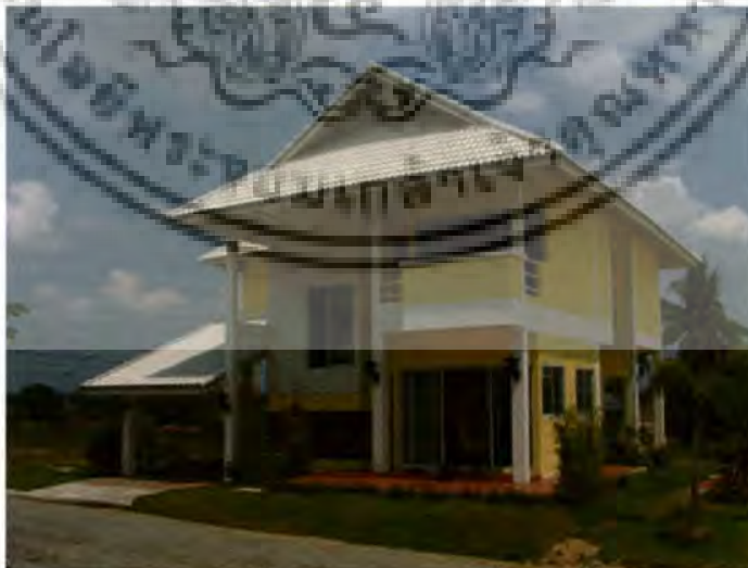
รูปที่ 9 การใช้ประโยชน์จากระเบียงชั้นบนและชายคายื่นยาวเพื่อลดผลกระทบด้านความร้อนและสอดคล้องกับสภาพภูมิอากาศของเขตร้อนชื้น (Tropical Climate)
