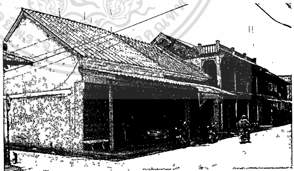
รูปภาพที่ 3.10 แสดงการซ่อมแซมอาคารตึกแถวเก่า
