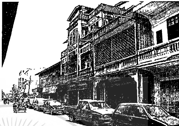
รูปภาพที่ 3.31 แสดงอาคารโรงแรมกาญจนบุรี ซึ่งมีความสูงกว่าอาคารประเภทอื่นๆ ในกลุ่มอาคารที่มีอายุใกล้เคียงกัน
