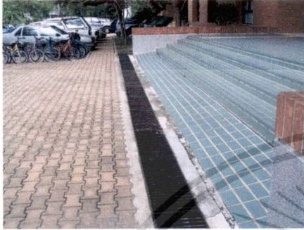
รูปหมายเลข 52 รูปตะแกรงระบายน้ำ
