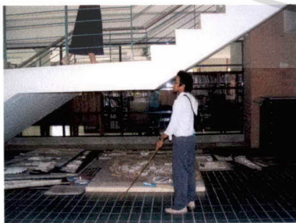
รูปหมายเลข 54 รูปอันตรายบริเวณทางเดินได้บันได 2
