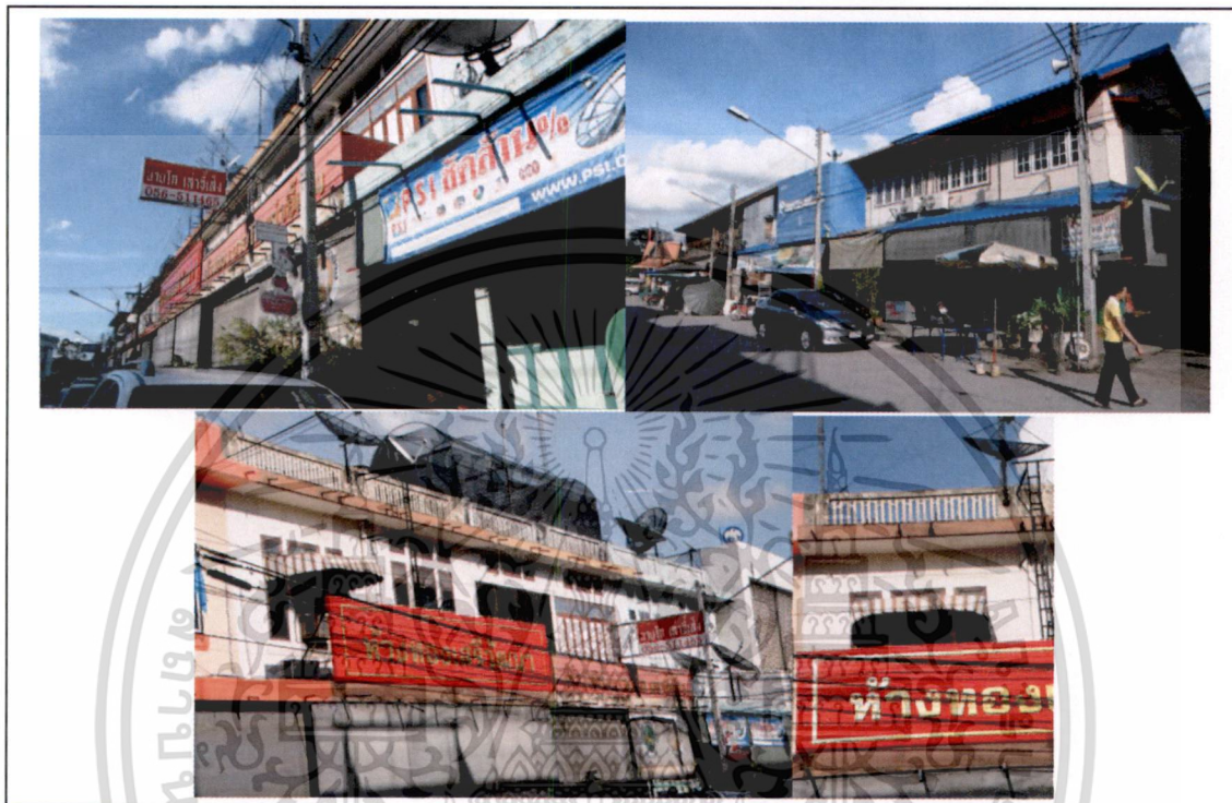
ภาพที่ 4.11 แสดงตัวอย่างสิ่งปิดบังอาคารที่พบในชุมชน
