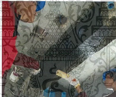
รูป 2.14 การหุ้มด้วยพอลิเมอร์เสริมเส้นใย
