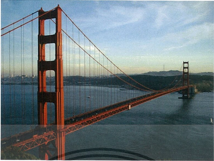
รูปที่ 2.5 Golden Gate Bridge, San Francisco , 1933
