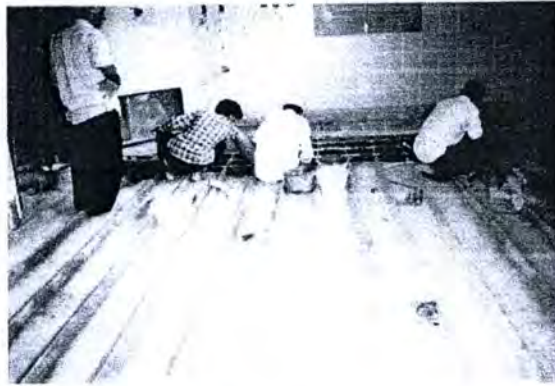
ภาพที่ภาคผนวก 34 การทำให้พื้นเป็นสื่อไฟฟ้าลงดิน โดยต่อลวดทองแดงลงดิน หรือใส่ตะแกรงทองแดงลงไป ในพื้นที่หรืออาจทำเป็นหินขัดแล้วแบ่งเส้นลวดทองแดงไว้เป็นตารางให้ที่ ก็สามารถแก้ปัญหาการเกิดไฟฟ้าสถิตย์ได้
